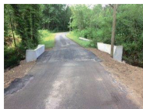
Routes communales avant et après les travaux
